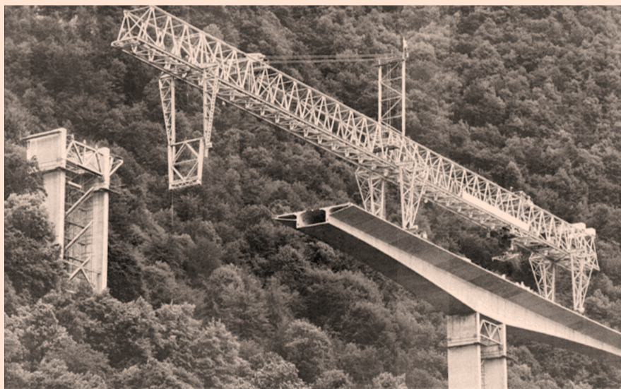
Viadukt von Chillon
